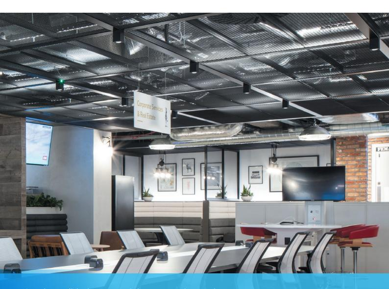
Streckmetalldecken mit sichtbarer Unterkonstruktion
